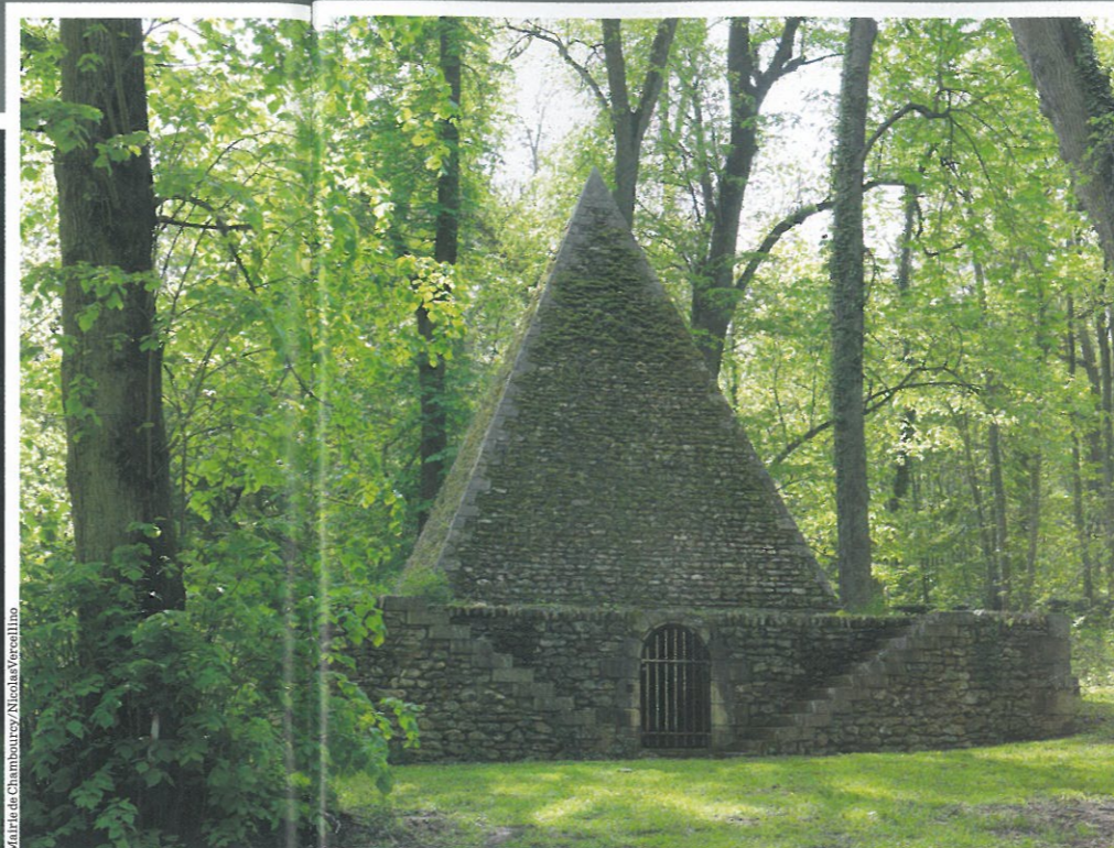
FRIGIDAIRE TROIS-POINTS. Cette pyramide cache une glacière, qui permet, l'été venu, de déguster des sorbets, alors très en vogue. Son architecture évoque la perfection chère à l'esprit maçonnique.
